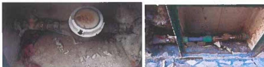
Figura 2. - Métodos utilizados para consumir água de forma ilícita
